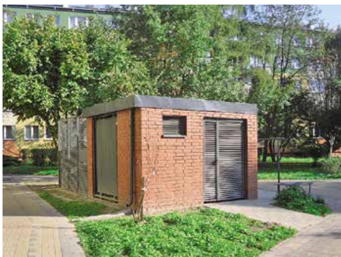
Wyremontowana altana śmietnikowa przy budynku Skrzetuskiego 2A - elewacje południowa i zachodnia.
