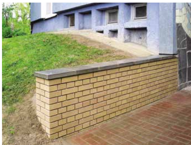
4. Nowy murek oporowy przy budynku Balladyny 2.
