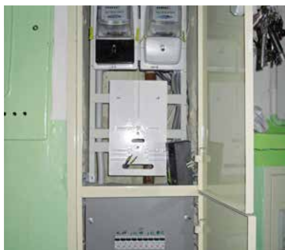
6. Wyremontowana tablica piętrowa w budynku Skierki 1.
