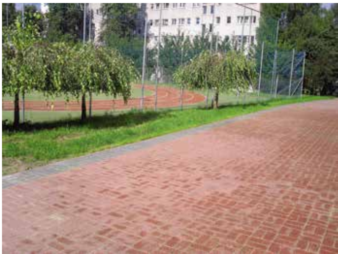
1. Wyremontowana alejka wzdłuż budynku Administracji.
