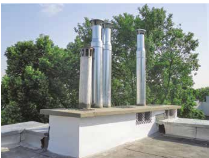
5. Wyremontowany komin w budynku przy ul. Balladny 20.
