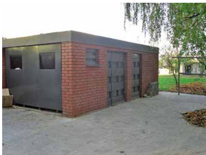
Wyremontowana altana śmietnikowa przy budynku Wołodajewskiego 6 - elewacje zachodnia i południowa.
