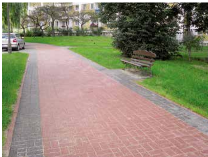
2. Wyremontowana alejka przy budynku Żana 12.
