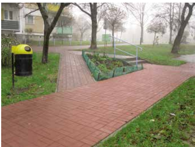
3. Wyremontowana alejka przy budynku Wileńska 15.
